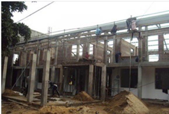
56 සේනාංක මූලස්ථානයෙහි නවකමයෙන් ඉදිකිරීම් කටයුතු කරනු ලබන කාර්යාල ගොඩනැගිල්ල රු: 6,000,000.00 ක මුදල් ප්‍රතිපාදන මගින් 98% ක් පමණ ඉදිකිරීම
