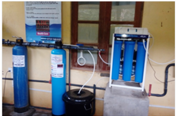
ජලය පිරිපහදු කිරීමේ යන්ත්‍ර - මෙම මූලයේ සහ 61 සේනාංක මූලස්ථානය ඉදිකිරීම
