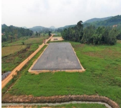
බොරළු ස්ථරයක් යොදා මෘදු බිම් සැකැස්ම
