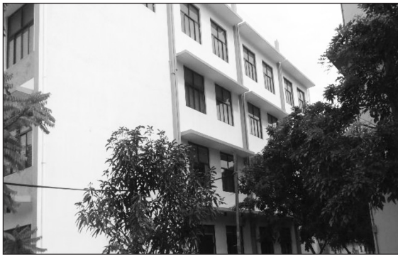
நிருவாகக் கட்டிடம் - கட்டம் 11 வயம்ப பல்கலைக்கழகம், குளியாபிட்டிய. மதிப்பீட்டுக் கிரயம் 290.0 மி.ரூ.
