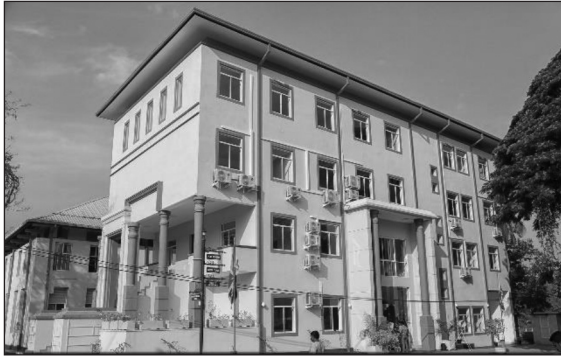
பொறியியல் தொழில்நுட்ப ஆய்வுகூடக் கட்டிடம், வயம்ப பல்கலைக்கழகம், குளியாபிட்டிய. மதிப்பீட்டுக் கிரயம் 282.0 மி.ரூ.
