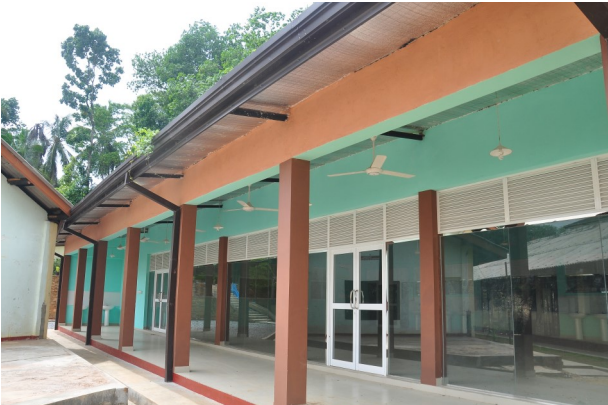
ආපනශාලාව - ගලගෙදර ම.ම.වි, මධ්‍යම පළාත
