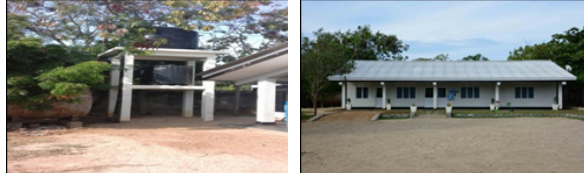
වෙරළ ආරක්ෂක අනුබණ්ඩ කිරීමේදී ජල ටැංකි රඳවනය ඉදිකිරීම (වම්) වෙරළ ආරක්ෂක අනුබණ්ඩ කිරීමේදී පොදු හෝජනාගාරය ඉදිකිරීම (දකුණ)
