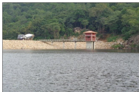
Kalugal Oya Sluice
