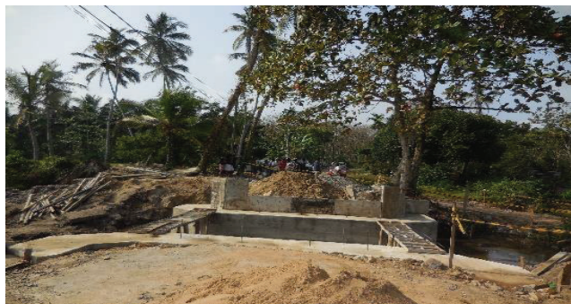
මිල්ලනියේ දොඹගොඩ සිලරතන මාර්ගයේ කුඩා පාලම සහ රැඳවුම් තාප්පය ඉදිකිරීම
