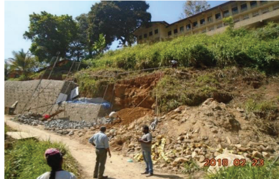
රඹුකේ ඇල මුස්ලිම් විද්‍යාලයේ ආනායක මාවත බෑවුම ස්ථායීකරණය කිරීම
