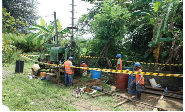
හංවැල්ලේ සිට කඩුවෙල දක්වා කැලණි ගංවතුර පාලන බැම්ම ඉදි කිරීමට අවශ්‍ය භූ විද්‍යාත්මක සමීක්ෂණයට අනුව සවිස්තරාත්මක සැලසුම් සකස් කිරීමට අවශ්‍ය දත්ත ලබා ගැනීමට මිහිවිහිදුම් සිදුකරන ආකාරය
