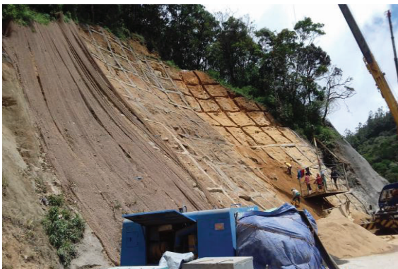
හක්ගල පේරාදෙණිය වෙන්කලඬි මාර්ගයේ හක්ගල උද්භිත උද්‍යානය අසල නායයාමට ලක්වූ ස්ථානය ස්ථායීකරණය කිරීම
