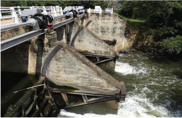
ඉලක්වැව අමුණ සඳහා ගියර් මගින් ක්‍රියාත්මක වන රේඩියල් ගේට්ටු ස්ථාපනය කිරීම 3ක්
