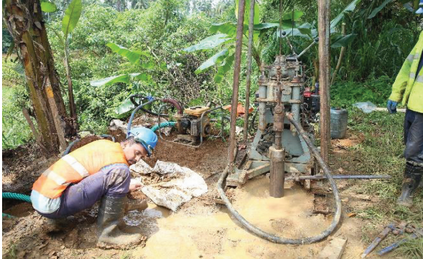
හංවැල්ලේ සිට කඩුවෙල දක්වා කැලණි ගංවතුර පාලන බැම්ම ඉදි කිරීමට අවශ්‍ය භූ විද්‍යාත්මක සමීක්ෂණයට අනුව සවිස්තරාත්මක සැලසුම් සකස් කිරීමට අවශ්‍ය දත්ත ලබා ගැනීමට මිහිවිහිදුම් සිදුකරන ආකාරය
