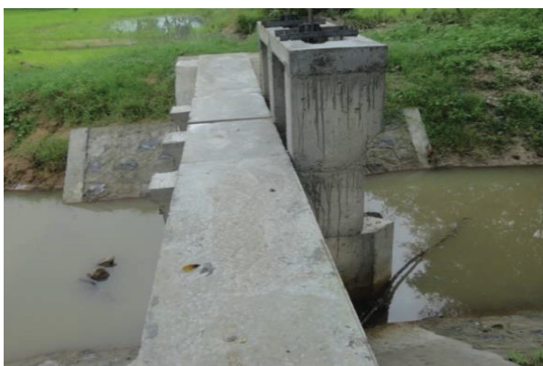
රූගම් කොට්ඨාශයේ වාහනේරි ව්‍යාපාරයේ පාලන නිර්මිතය ඉදිකිරීම
