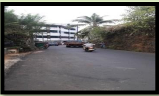
கஜுகல்வத்த பாதையின் எஞ்சிய பகுதி காபட் இடுதல் (Road Carpeting)
