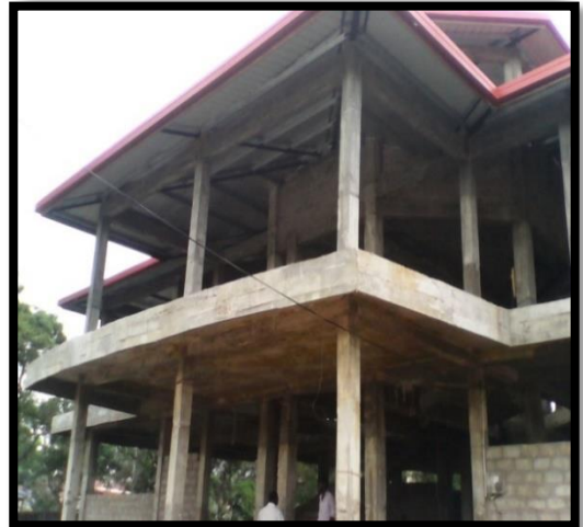
සංචාරක බංගලාව සඳහා දෙමහල් ගොඩනැගිල්ල ඉදිකිරීම - III අදියර
