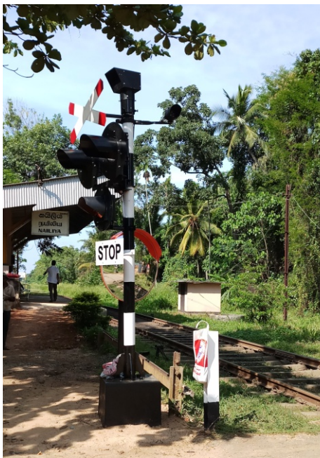
නයිලිය දුම්රිය ස්ථානය අසල දුම්රිය හරස් මාර්ගය සඳහා පිහිටවූ විදුලි සිහු අනතුරු ඇඟවීම් සංඥා පද්ධතිය
