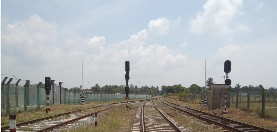
කටුනායක දුම්රිය ස්ථානයේ ද්විත්ව මාර්ගය සඳහා සිදුව දෙසට පිහිට වූ පිටත්වීමේ සංඥා
