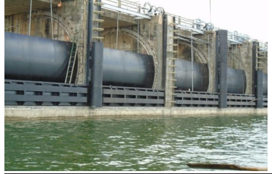
ராஜாங்கனய அணைக்கட்டில் நீர்க் கட்டுப்பாட்டுக் கதவுகள்
