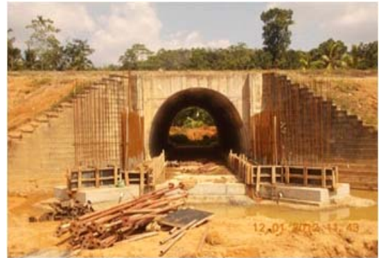
CH 35+090யில் RCBU விஸ்தரிப்பிற்காக வலுவூட்டல்
