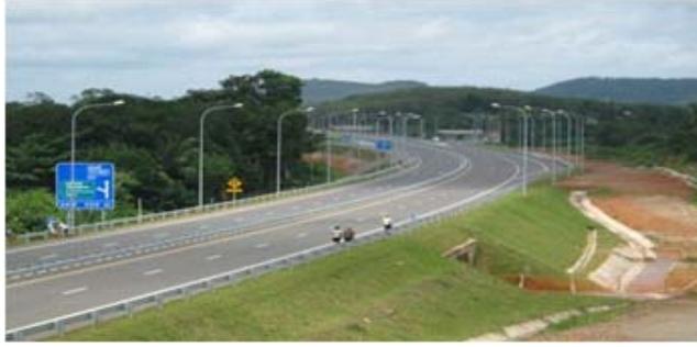
Ch47+000 இல் இருந்து வட காட்சி
