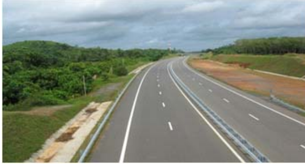
CH37+500 இல் இருந்து வட காட்சி
