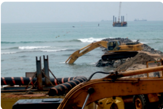
උනාව කලපුව අසලම අපජලය බැහැරලන මුහුදු පිටදොර නිර්මාණ කටයුතු
