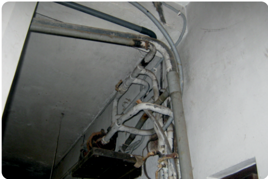
අතවසර ජල පරිභෝජනය සම්බන්ධයෙන් උදාහරණයක් (සවිකර ඇති තලයකින් අතුරු මගකින් පොම්පයක් මගින් ජලය ලබා ගැනීම)
