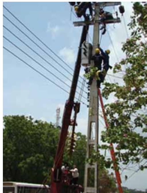
නිෂ්පාදකයා විසින් LBS ලබා දෙන ධාරිතා ඔණ්ඩන සවි කිරීම පිළිබඳ පුහුණුව
