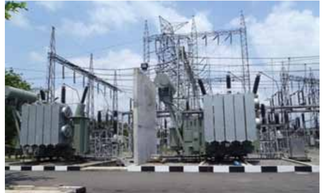
කොටුගොඩ ග්‍රිඩ් උප මධ්‍යස්ථානයේ 2X31.5 මෙ.වො.ඇ. තරාපැව් සවිකරනු ලැබීය.
