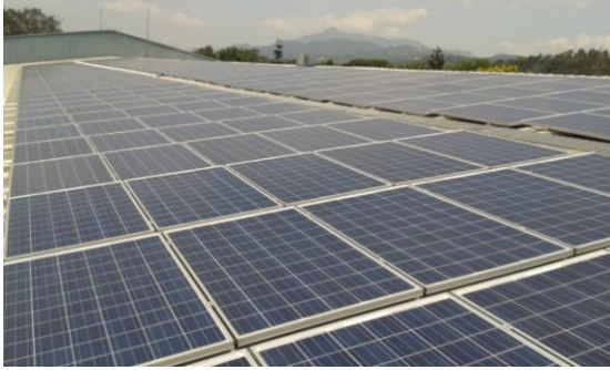
පල්ලෙකැලේ මාස් හෝල්ඩින්ග්ස් ආයතන පරිශ්‍රයේ 100 kWp සූර්ය පද්ධතියක් ස්ථාපිත කිරීම
