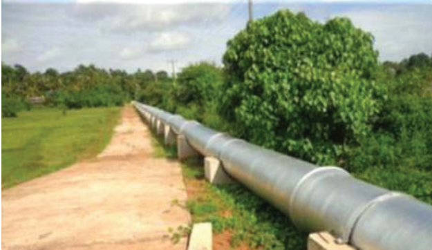
බණ්ඩාරගම සිට පිළියන්දල දක්වා දිවෙන DI 1000/800 ප්‍රධාන සම්ප්‍රේෂණ නල මාර්ගය
