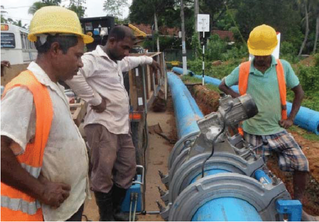
බද්දේගම හික්කඩුව අධිවේගී මාර්ග ප්‍රවේශ මාර්ගයේ නල මාර්ග වලීම.
