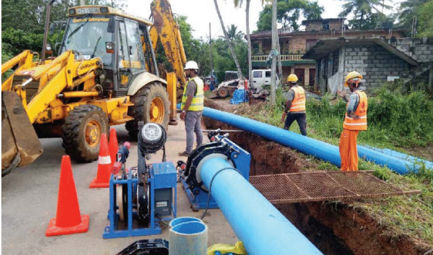
මිගොඩ - දාමපේ මාර්ගයේ විෂ්කම්භය මිලි මීටර 355 නල පැස්සීමේ සුදානම.
