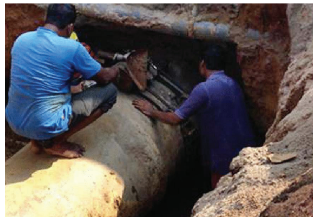
බියගම - මාඩිම ජලනල ඇතිරීම
