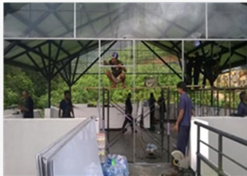
අයගම බස් නැවතුම්පළ ගොඩනැගිල්ල සකස්කරදීම
