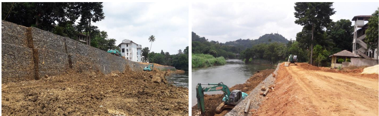
ගේබියන් බැම්ම ඉදි කිරීම
