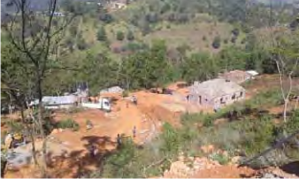
MHPP இன் மீள்குடியமர்த்தல் வீட்டுத்திட்ட நிருமாணம்
