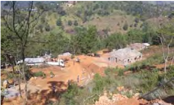
මොරගොල්ල ජල විදුලි යෝජනා ක්‍රමය යටතේ හැවත පදිංචි කිරීම් සඳහා කරන ඉදිකිරීම්
