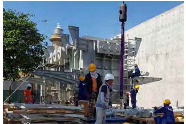
“L” වන ජාල උපපොළෙහි MVA 250 තාරාපැවියෙහි ස්ථාපන වැඩ
