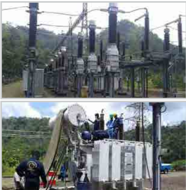
කුකුල් ගඟ බලාගාරයෙහි වහරු අංගනයේ පිහිටි 10 MVA තාරාපැවියෙහි උපුටු මාරාකැරුව සර්විස් කිරීම
