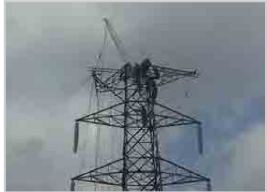
කි.වො. 132 කුළුණු රැහැන - බියගම රැහැන, බිම් ගැන්වුම් ප්‍රතිස්ථාපනය
