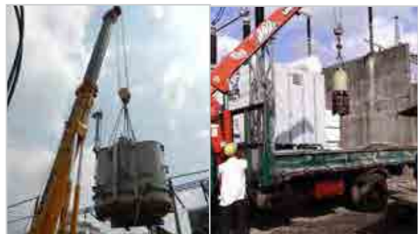
බියගම් කොටුමා උපපොළෙහි දෝෂ සහිත තනි පරිපථ MVA 250/3 කි.වො. 220 - 132/33 තාරාපැව්ගේ ප්‍රතිස්ථාපනය කිරීම.
