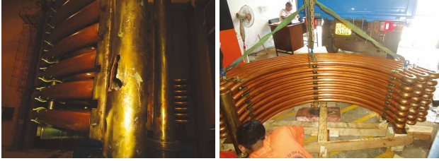
உதைப்பு மற்றும் UGB எண்ணெய் குளிராக்கியில் ஏற்பட்ட கசிவு காரணமாக சேதங்களின் செயலிழப்புப் பராமரிப்பு
