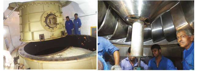
பகுதியாக அகற்றப்பட்ட உறிஞ்சல் ரண்ணருக்கு பொருத்தப்பட்ட கூம்பின் கீழ்ப் பகுதி புதிய மூக்குக் கூம்பு
