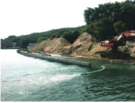
නාවික ජැටිය ඉදිකිරීම - ත්‍රිකුණාමලය / ඉට්ටි කට්ටුමානම - තිරුකොණමමෙ / Construction of Navel Jatty - Trincomalee
