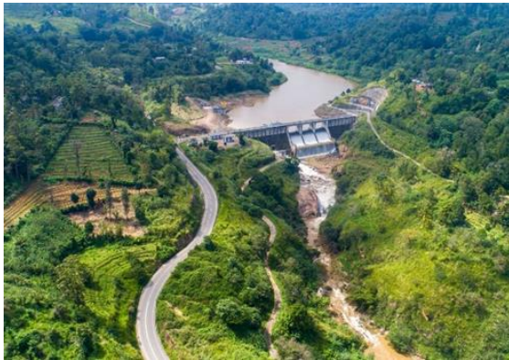
புதுல்போல லேட் / புஹுல்பொல அணைக்கட்டு / Puhulpola Dam
