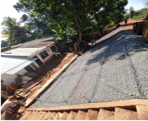
කැළණි උතුරු බැම්ම ප්‍රතිසංස්කරණය කිරීම /களனி வடக்கு கரை புனரமைப்பு/ Kelani North bund rehabilitation
