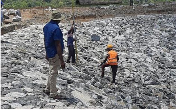
Rip Rap ஓடிகிரீம கஞ்சுறு / Rip Rap கட்டுமான பணிகள் - அம்பாறை / Rip Rap Construction works – Ampara
