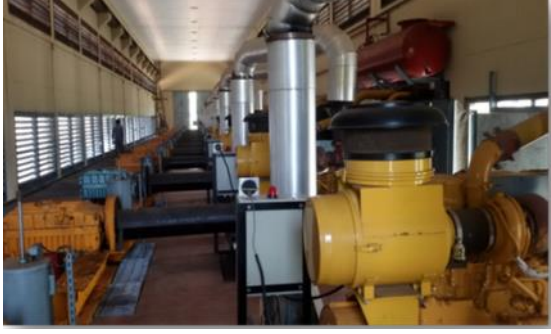
තල්ගහගොඩ පොම්පාගාරය වැඩිදියුණු කිරීමේ කටයුතු / தல்கஹகொட நீரிரைப்பு நிலையமேம்படுத்தல் பணிகள் / Improvements work – Thalgahagoda Pump House
