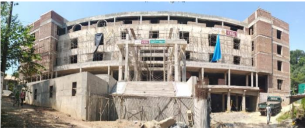
රත්නපුර අධිකරණ සංකීර්ණය ඉදිකිරීම / ඉරත්තිනපුරියිල් ත්‍රිමනර් වලාකම කට්ටුම / Construction of Court Complex at Rathnapura
