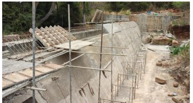
පිට්ටානෙහි ඉදිකිරීම් කටයුතු/ கசிவு கட்டுமானம்/ Construction of Spill
