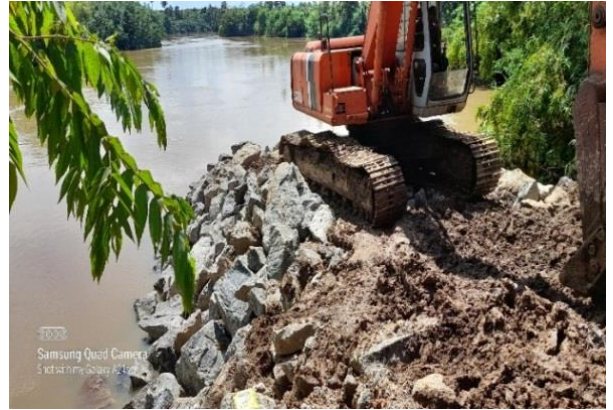
මහ මය බාදන වාරක ඉදිකිරීම / மகா ஓயாவின் groynes ஐ நிர்மாணித்தல் / Construction of groynes in Maha oya
