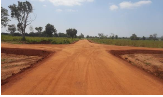
தாவத ப஢ி கிரிதே துதேதல லாரத ஓ஢ிகிரிதே கததது / தீளகுடிதேற்ற பகுதிகளில் தீதி நிர்மாண நடவடிக்கைகள் / Road Construction works for Resettlement Area
