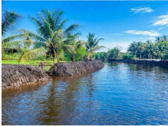
බෙන්තර ගඟ දකුණු ඉවුර ව්‍යාපාරයේ ඇලවල් පවිඳු කිරීම / பெந்தர கங்கையின் வலதுகரைத் திட்டத்தினை சுத்தப்படுத்தல் / Canal clearing at Bentara RB scheme
