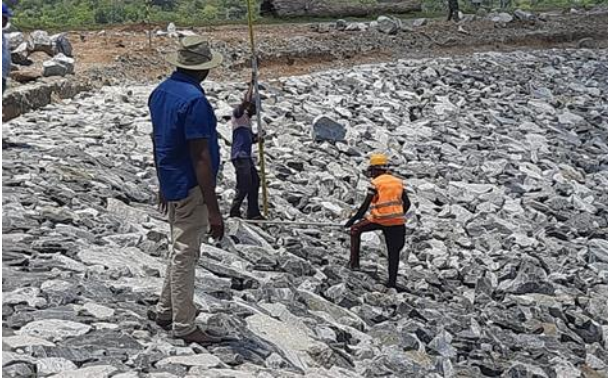
Rip Rap ஓடீகரீ஑ க஑஑ுறு / Rip Rap கட்டுமான பணிகளீ - அம்பாறே / Rip Rap Construction works – Ampara
