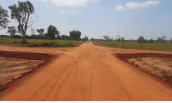
தரவன ப஢ிஃ கிரீஃ ப்ர஢ே஢வல ஃர்ட ஓ஢ிகிரீஃ கஃப்யூ / ஢ீள்குடிபேற்ற பகுதிகளில் வீதி ஢ிர்஢ாண ஢டவடிக்கைகள் / Road Construction works for Resettlement Area
