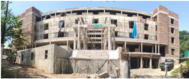
රත්නපුර අධිකරණ සංකීර්ණය ඉදිකිරීම / இரத்தினபுரியில் நீதிமன்ற வளாகம் கட்டுதல்/ Construction of Court Complex at Rathnapura
