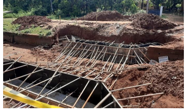
டேவ஑ுவ ஑ேச்சனா னுமே ஈுல லாரீயே ஓடீகரீ஑ - டீ஑ுடீல / தேவா஑ுவா திட்டத்திலீ கால்வாய் நிரீமாணம் / Canal Construction of Dewahuwa Scheme
