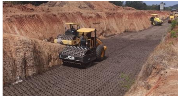
පස් වෙලි ඉදිකිරීම් කටයුතු/ மண்வேலைகளின் கட்டுமானம் / Construction of Earthen Embankment Works
