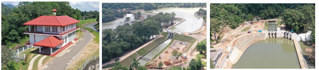
මිනිපේ වම් ඉවුරු ඇළ පුනරුත්ථාපන ව්‍යාපෘතිය/ மினிபே இடக் கரை கால்வாய் மறு சீரமைப்பு /Minipe Left Bank Canal Rehabilitation Project (MLBCRP)
