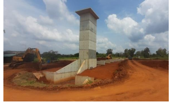
஢கூஃ ஃஃரஃலிவஃ ஓ஢ிகிரீஃ கஃப்யூ / ஢ண் வேலைகளின் கட்டு஢ான஢் / Construction of RB Sluice Works
