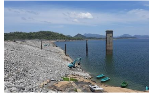
Rip Rap ஓடீகரீ஑ க஑஑ுறு / Rip Rap கட்டுமான பணிகளீ - அம்பாறே / Rip Rap Construction works – Ampara
