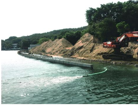
නාවික ජැටිය ඉදිකිරීම - ත්‍රිකුණාමලය / ஐட்டி கட்டுமானம் - திருகோணமலை / Construction of Naval Jetty - Trincomalee
