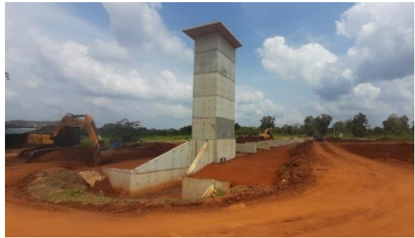
දකුණු සොරොව්වෙහි ඉදිකිරීම් කටයුතු / மண் வேலைகளின் கட்டுமானம் / Construction of RB Sluice Works
