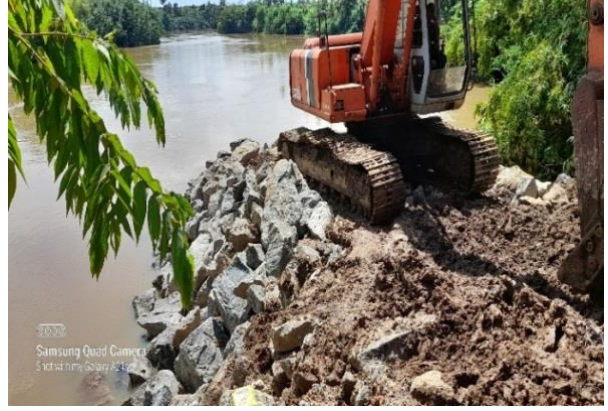
මඟ ඔය බාදන ආරකුණ වැටි ඉදිකිරීම / මකා ඉආාවිලු groyne ආු නිර්මාණිත්තලු / Construction of groyne in Maha oya
