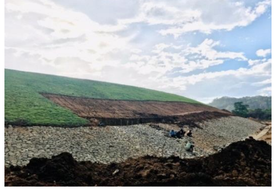
හිම්බිලියාකඩ වැව හා වැව් බැම්ම ප්‍රතිසංස්කරණය කිරීම /ஹிம்பிலியாகட குளம் மற்றும் குளக்கரையை புனரமைத்தல் /Rehabilitation of Himbilyakada tank and tank bund
