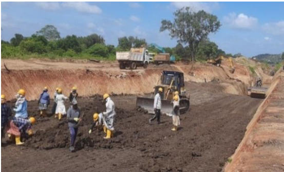
පස් වේලි ඉදිකිරීම් කටයුතු / மண் வேலைகளின் கட்டுமானம் / Construction of Earthen Embankment Works
