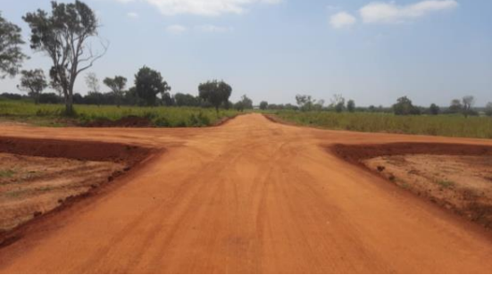
නැවත පදිංචි කිරීමේ ප්‍රදේශවල මාර්ග ඉදිකිරීමේ කටයුතු / මීඟ குடியமர்த்தப்படும் பிரதேசங்களுக்கு பாதை அமைத்தல் / Road Construction works for Resettlement Area/
