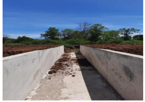
டெபர ஂர பரீதல ஂர ஓடலகரீம / தெபர ஂர னட்டற காலவாய் அமலத்தல்/ Construction of Debara Ara feeder canal
