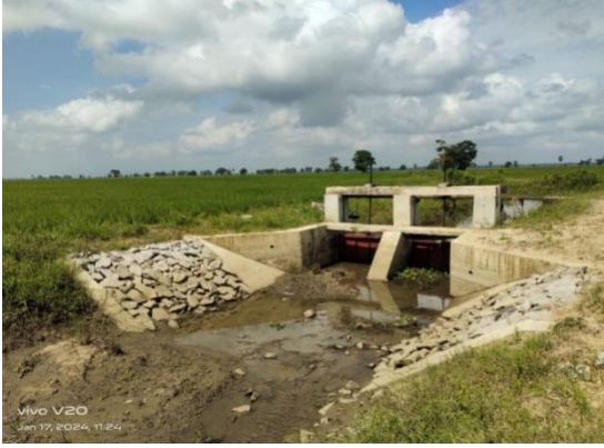
අම්පාර කලාපයේ ඔට්ටයන්මඩු බැමීමේ සින්තවේලි ජලාපවහන අවසානයේ ජලාපවහන පිටවනක් ඉදිකිරීම අම්පාறை பிராந்தியத்தின் ஓட்டடையன்மடு அணையின்சின்னவேலி வடிகாலின் இறுதியில் வெளிச் செல்லும் வடிகால் ஒன்றை நிர்மாணித்தல் /Construction of drainage outlet in end of sinnaveli drainage in Ottayanmadu Bund in Ampara Region
