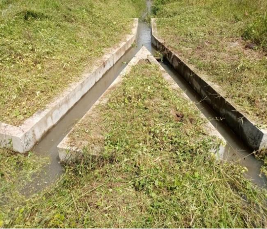
මහනුවර කලාපයේ මහගෝනවැව යෝජනා ක්‍රමයේ වතුර බෙදීමේ ව්‍යුහයන් 04ක් ඉදිකිරීම /கண்டி பிராந்தியத்தின் மககோணவெவ உத்தேசத் திட்டத்தில் நீர் பகிர்ந்தளிக்கும் கட்டமைப்புகள் 4/ நிர்மாணித்தல் Construction of 04 numbers of Bifurcation structures in Mahagonawewa Scheme in Kandy Region
