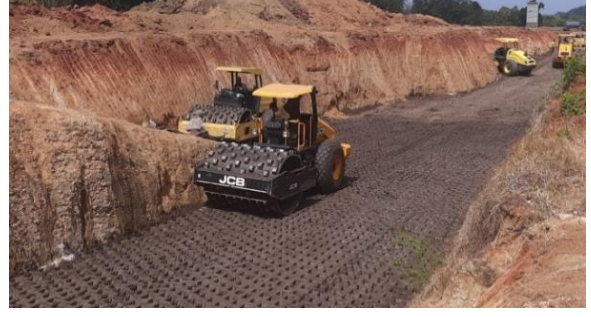
පස් වේලි ඉදිකිරීම් කටයුතු / මண் வேலைகளின் கட்டுமானம் / Construction of Earthen Embankment Works
