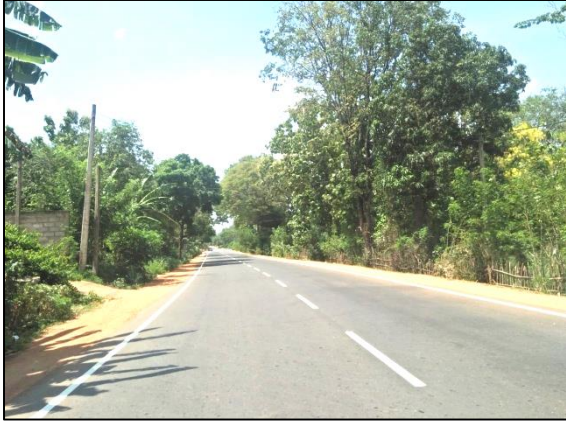
வீதிவலயமைப்புஅபிவிருத்தித்திட்டம் - கண்டி-யாழ்ப்பாணம் வீதியில் 53+740 km to 58+ 000km வரை
