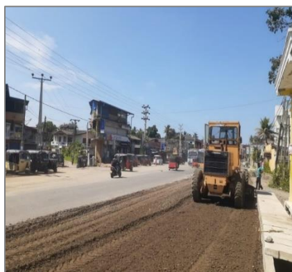
ABC Layer Preparation at Ch.7+030-7+060 RHS
