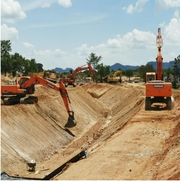
ප්‍රධාන ඇල ඉදිකිරීම/ பிரதான கால்வாய் கட்டுமானம்/ Construction of Main Canal
