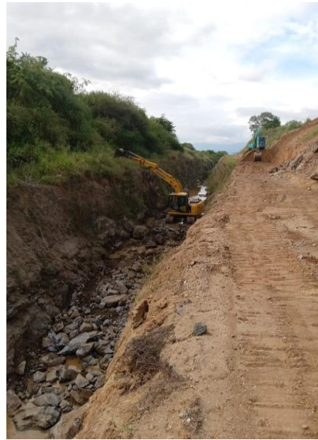
சோதீன ஈரூலீ கலீ தரீ கலா ஓவன் கரீம்/ பாறா அகழ்வு/ Rock blasting along the canal trace
