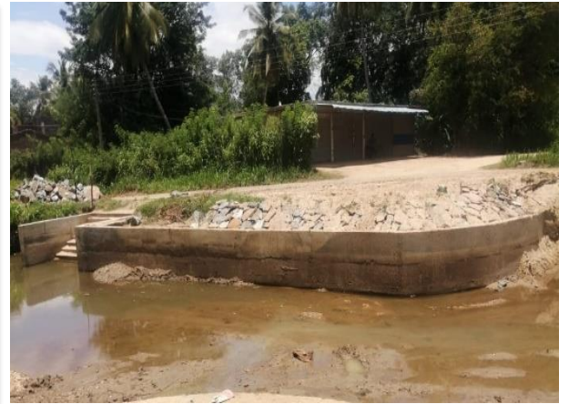
நாகதீப அடி/ நாகதீப கால்வாயில் R/W மற்றும் குளிக்கும் படி/ R/W and Bathing step at Nagadeepa canal
