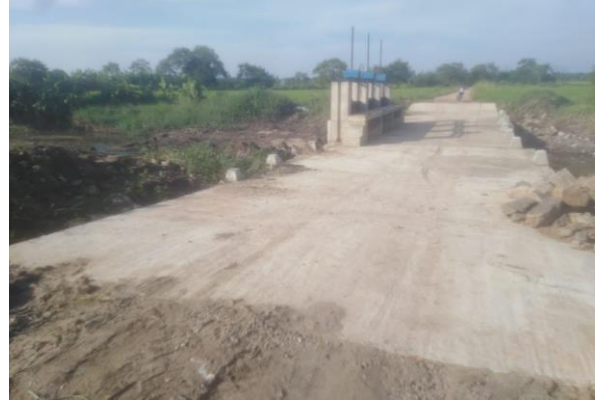
කවුඩුල්ල ව්‍යාපාරයේ වවුල්බෝක්කුව අපවහන ඇළ හැරවුම් පද්ධති ඉදිකිරීම/ கவுடுள்ள திட்டத்தில் வவல்பொக்குவ வடிகால் கால்வாயில் 3 விரிகுடா ஒழுங்குபடுத்தல் நிர்மாணம்/ Construction of 3 bay regulator in Wavlbokkuwa Drainage canal in kawdulla scheme
