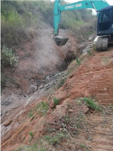
சோதீன ஈரூலீ கலீ தரீ கலா ஓவன் கரீம்/ பாறா அகழ்வு/ Rock blasting along the canal trace
