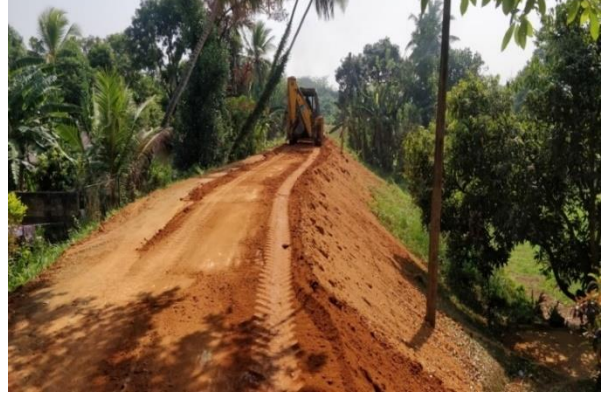
උතුරු වෙල්ල පුනරුත්ථාපනය/ වැට්ටු කරා මෙර්ටු පුනරාමාප්ප/ Rehabilitation of North bund
