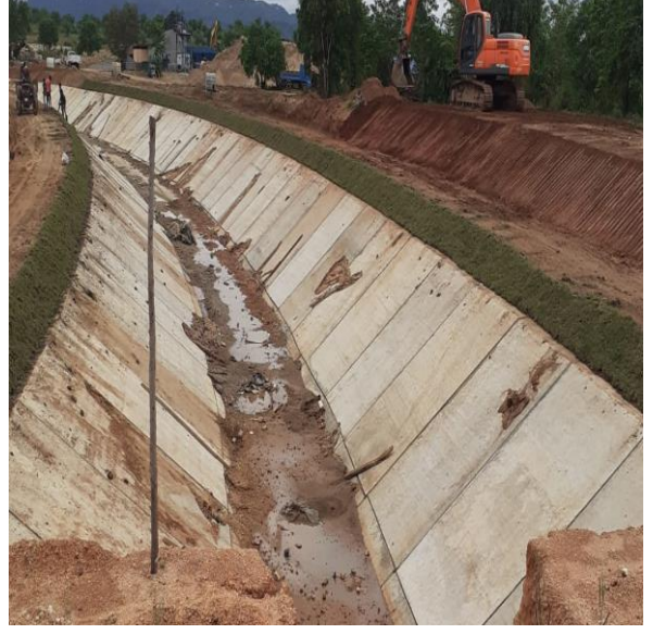
ප්‍රධාන ඇල ඉදිකිරීම/ பிரதான கால்வாய் கட்டுமானம்/ Construction of Main Canal
