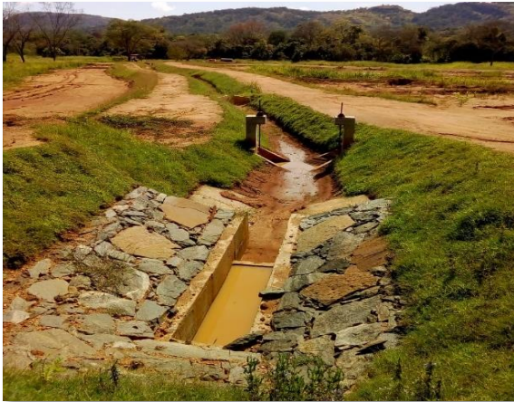
முதல் அடி அடி அடி அடி/ டி3 கால்வாயில் புத்தரை/ Turfing in D3 Canal
