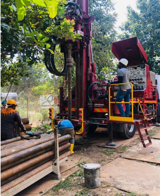
පරීක්ෂණ ලිං කැණීම/ கண்காணிப்பு கிணறு தோண்டுதல்/ Drilling of Monitoring well
