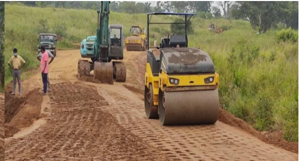
ප්‍රධාන ඇලෙහි ව්‍යුහයන් ඉදි කිරීම/ පිරිතාන කාලය/ ප්‍රධාන ඇල ව්‍යුහයන් ඉදි කිරීම/ පිරිතාන කාලය කඳුකරයේ/ Construction of main canal structures අනුකූල වීම්/ Construction of access road
