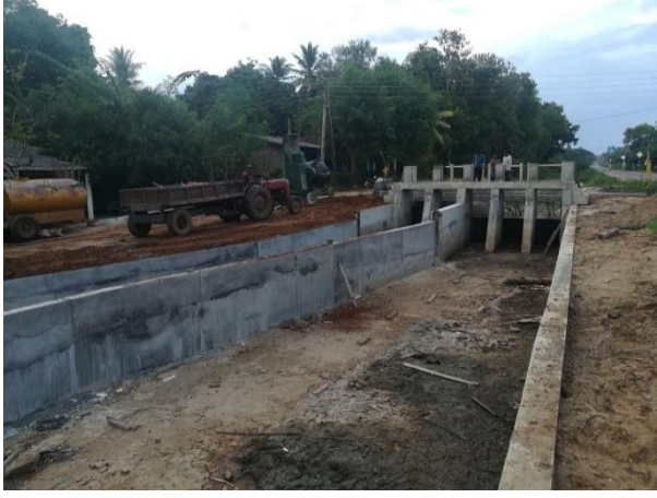
லீதீதீன லுசுதய ஓரீகரீம்/ பரரர்ப்பு க் கட்டமர்ப்பு நரீர்மரணர்த்தல்/ Construction of Bifurcation Structure
