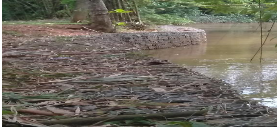
அத்தனகல ஓயா ஆற்றின் அருகாமையில் அமைக்கப்பட்டுள்ள பாதுகாப்பு மதில்; (Gabion Wall)
