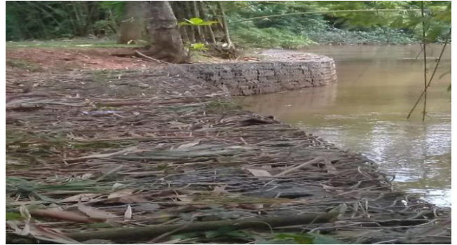
උද්භිද උද්‍යානය දිගේ පිහිටි අත්තනගලු ඔය ඉවුර සංරක්ෂණය සඳහා ඉදි වූ ගේබියන් තාප්පය
