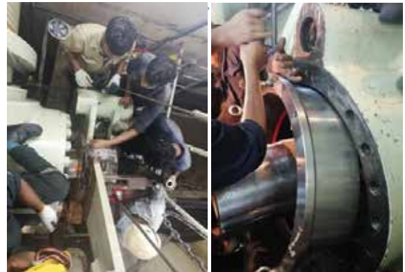
සර්වෝ මෝටර සම්බන්ධකය ගැලවීම
