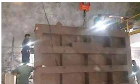
කොත්මලේ විදුලි බලාගාරයේ පිවිසුම් ද්වාරය, ටර්බයින් ජල පිටවුම් ද්වාරය, සර්පන කුටි ද්වාරය හා ව්‍යුහයන්හි මතුපිට පිරිසිදු කිරීම හා පිත්තාරු කිරීම
