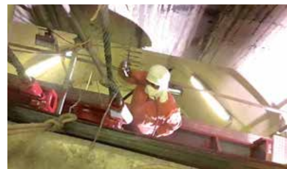
කොත්මලේ විදුලි බලාගාරයේ පිවිසුම් ද්වාරය, ටර්බයින් ජල පිටවුම් ද්වාරය, සර්පන කුටි ද්වාරය හා ව්‍යුහයන්හි මතුපිට පිරිසිදු කිරීම හා පිත්තාරු කිරීම
