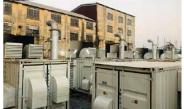
கொலன்னாவை தளம் - 02 இல் 1 MW மின் பிறப்பாக்கிகள்
