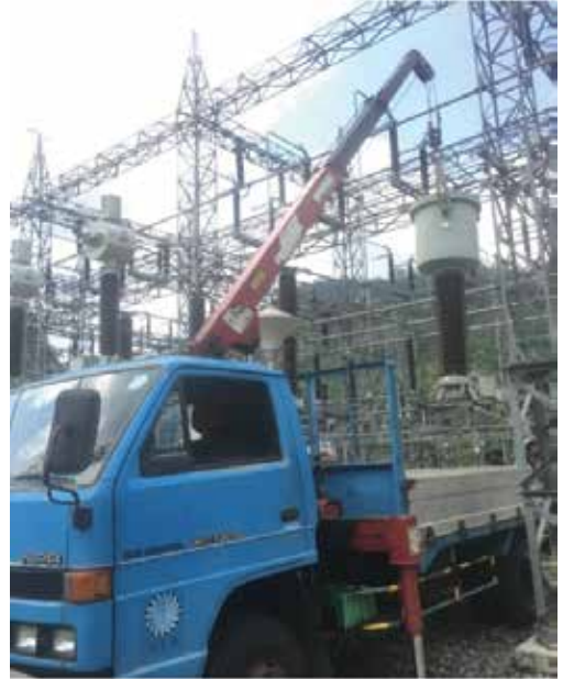
Figure Tr.10: உக்குவளை GS இல் 132 kV CTs இன் மாற்றிடு
