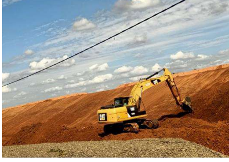
ஹெல்ப் ஸுஹைம் ஸஹ நஹகோல ஈலீலீம்/ சரிவு தயாரிப்பு மற்றும் புல் வெட்டுதல்/ Slope Stripping & Turfing
