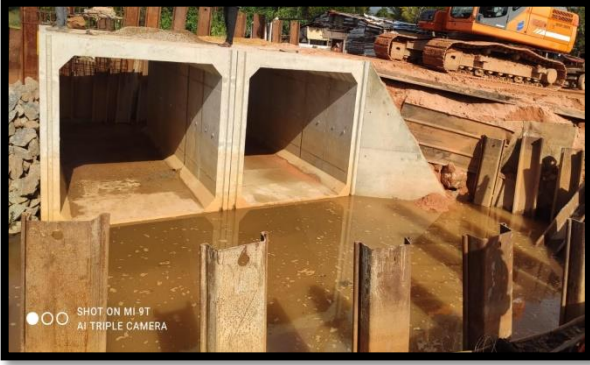
உருப்படம் 5: நிர்மாணிக்கப்பட்டுள்ள பெட்டி வடிவ மதகு
