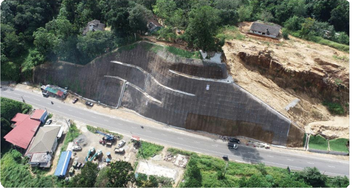
மண்சரிவு தணிப்பு பூர்த்தி செய்யப்பட்ட தலம் - தல இல: 011 கேகாலை பை-பாஸ் வீதி (தொகுப்பு 04C)
