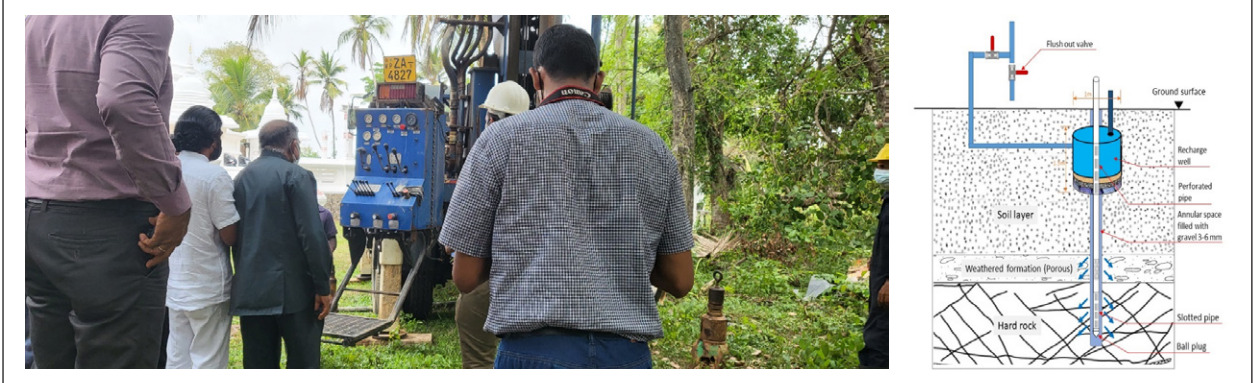
படம் 22: பெம்முல்லை ஸ்ரீ வர்தன பிரிவெனாவில் ஆழமான மீள்நிரப்பல் கிணறு தோண்டுதல் மற்றும் முன்மொழியப்பட்ட மீள்நிரப்பல் கட்டமைப்பு வரைபடம்.
