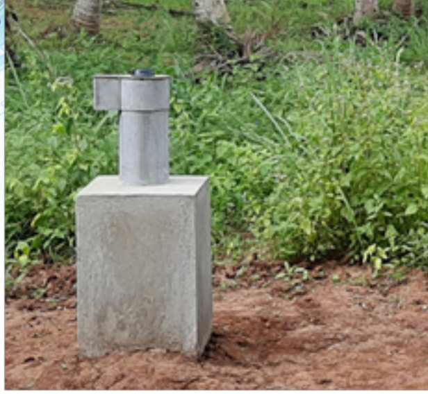
படம் 45 : றேளுனு மிஹிந்தலே நீர் வழங்கல் திட்டத்திற்கு அருகில் உள்ள நிகழ்நேர நிலத்தடி நீர் கண்காணிப்பு கிணறு ஒன்று உருவாக்கப்பட்டது மற்றும் வலையமைப்பு மூலமான காட்சி.
