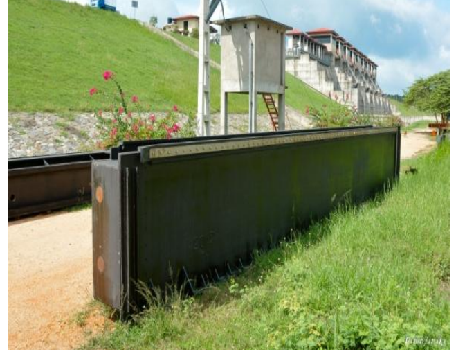
தெதுரு ஓயா திட்ட அவசர நீர் கட்டுப்பாட்டு கதவுகள்
