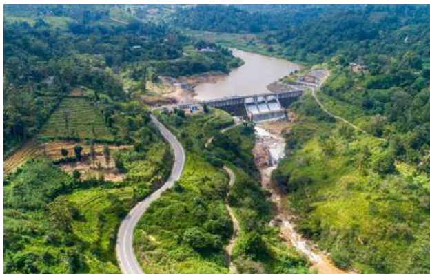
புதுல்போல லேட் / புஹுல்பொல அணைக்கட்டு / Puhulpola Dam
