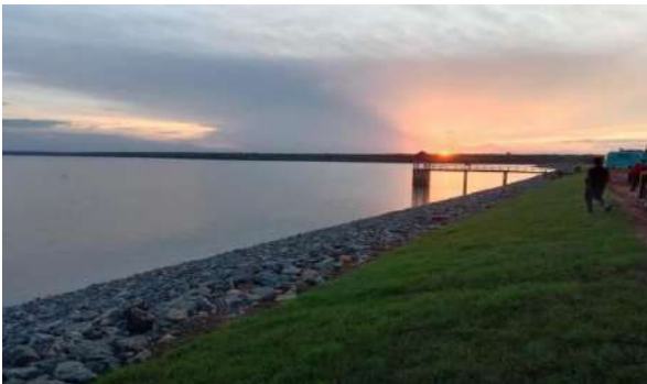
கல்மடூ கால்வாய் கால்வாய் கால்வாய் கால்வாய் - கல்மடூ / கல்மடூ திட்டத்தில் சீர்திருத்தங்கள் - மூலஸ்தை / Rehabilitation of Kalmadu Scheme Headworks
