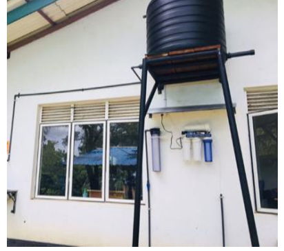
கூயாருப ஁க 44 - காதிக்கா ஁காரலீ ஸூரீ லீ஢ீரலக் ஸீ஢ீபனய கீரீம், ல஢ீன காதி நாக்கீன டீனூனய புகைப்பட ஁ண் 44 - தொழில்நுறை வகை குடிநீர் வடிகட்டியை நிறுவுதல் - பட்டஅத்தயில் உள்ள விவசாய தொழில்நுட்ப பூங்கா Photo No 44 - Installation of Industrial Type Drinking Water Filter, Batatha Agro Technology Park
