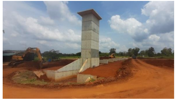
දකුණු සොරොවිවෙහි ඉදිකිරීම් කටයුතු / மண் வேலைகளின் கட்டுமானம் / Construction of RB Sluice Works
