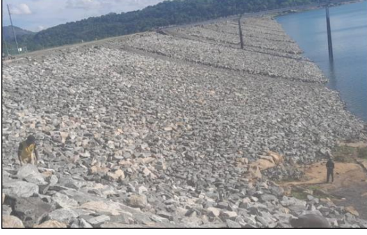
සේනානායක සමුද්‍රය බැම්මට ආරක්ෂාව සැපයීම/அக்கிடாமுறிப்பு அணையை மேம்படுத்துதல் /Providing of Rip-Rap Protection to Senanayaka Samudraya Bund
