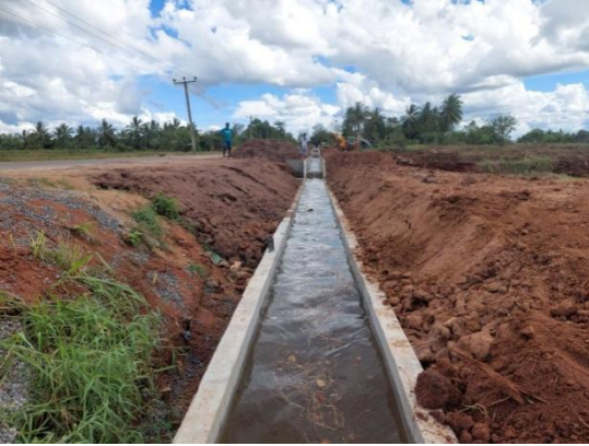
යාන් ඔය පහල නිම්නයේ ජයන්ති වැව D ඇල වැඩිදියුණු කිරීම / ஜயன்திவாவியின் கீழ் நீரோட்டத்தின் D கால்வாய் மேம்படுத்தல் / Yan Oya Downstream Jayantiwewa D canal Improvements
