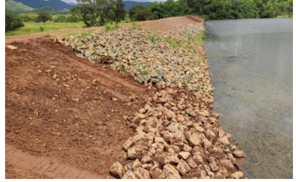
වැව් බැම්ම / தொட்டி கட்டு / Tank Bund
