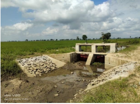
අම්පාර කලාපයේ ඔට්ටයන්මඩු බැම්මේ සින්තවේලි ජලාපවහන අවසානයේ ජලාපවහන පිටවනක් ඉදිකිරීම අම්පාறை பிராந்தியத்தின் ஓட்டையன்மடு அணையின்சின்னவேலி வடிகாலின் இறுதியில் வெளிச் செல்லும் வடிகால் ஒன்றை நிர்மாணித்தல் /Construction of drainage outlet in end of sinnaveli drainage in Ottayanmadu Bund in Ampara Region
