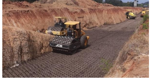
படி வெலி ஓடிக்கிரீமீ கவயு / மண் வேலைகளின் கட்டுமானம் / Construction of Earthen Embankment Works
