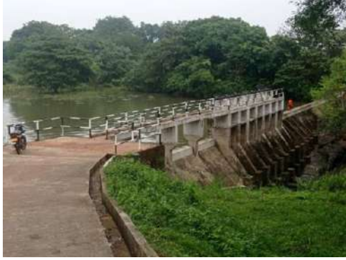
ஈரு வேவா ஸ்பில்வேயை உயர்த்துதல் / Raising Eru wewa spillway
