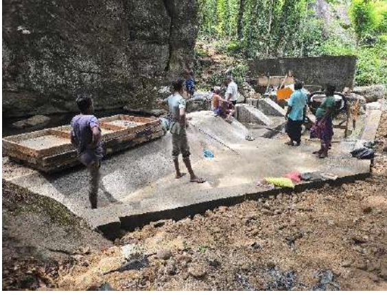
ගෝනමඩ මුකලාන වැව් රොන් මඩ උගුල/ கோனாமடா முகலான தொட்டி சேறு பொறி/ Gonamada Muukalana Tank Silt Trap
