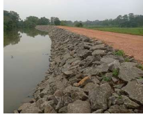
ஈர் ஓலுர் ஈரகீசையை/ ஆற்றங்கரை பாதுகாப்பு/ Canal bund protection
