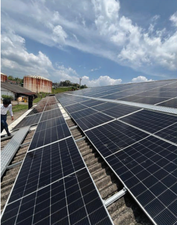
කොලොන්නාව පර්යන්තයෙහි 300kWp වෝල්ටීයතා සූර්යබල (PV) උත්පාදන පද්ධතියක් ස්ථාපනය කිරීම
