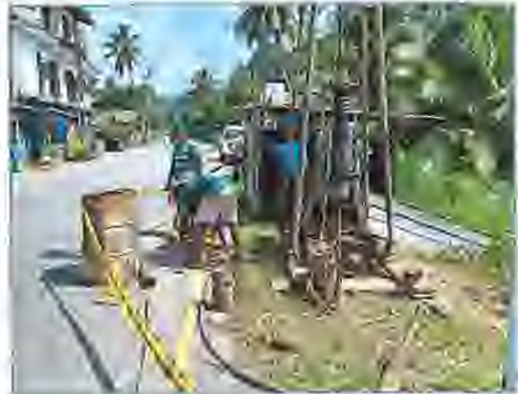
රූපසටහන 2-8: අම්බලංගොඩ - ඇල්පිටිය - පිටිගල මාර්ගයේ කි.මී. 22/5 දරණ ස්ථානයේ පිහිටි පාලම සඳහා මිහිවිදමන් විමර්ශනය
