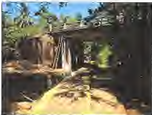
රූපසටහන 2-5: පමණින්න - කුඹල්ගම - රජවක - කපුගල මාර්ගයේ අංක 4/1 හි භානියට පත්වූ පාලමේ යාබැම්ම සහ පත්බැම්ම අලුත්වැඩියා
