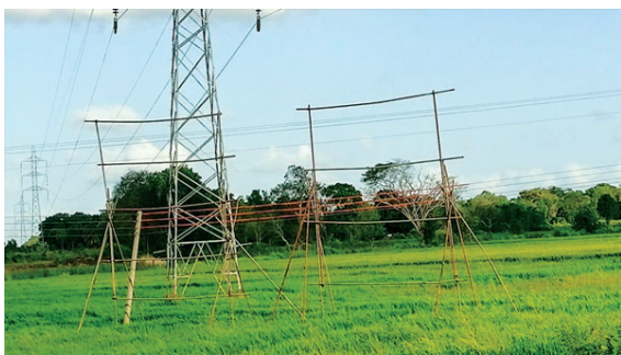
පැකේජය 4A, අනුරාධපුර - නව හබරණ රැහැන් මාර්ගයේ H107 –H115 කොටසේ රැහැන් ඉවත් කිරීමේ කටයුතු
