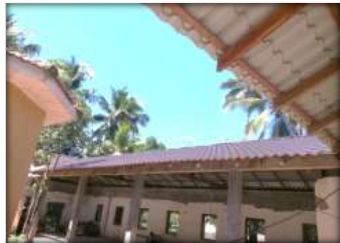
බියගම සුදර්ශනාරාම විහාරස්ථානයේ වහල ප්‍රතිසංස්කරණය කිරීම
