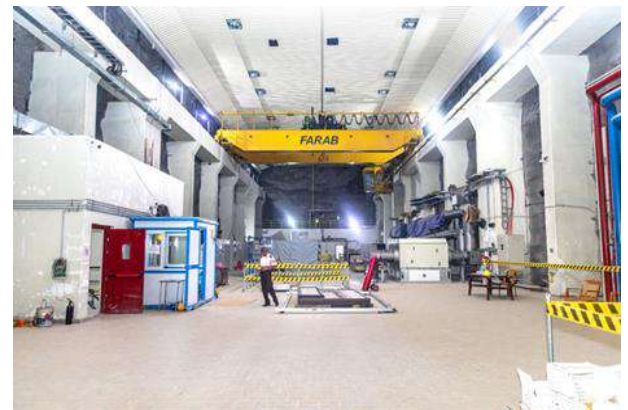
ஆழை லு஑ாரய/நிலத்தடி மின் நிலையம் /Underground power house
