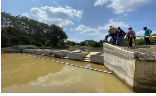
ඡායාරූප අංක 15 - Piano Key හැඩයෙන් පළමුවරට ව්‍යාපෘතිය ඉදිකළ මූලතිව් පුදුකුලම් වැවෙහි වාන ලෝක බැංකු නිරීක්ෂණ කණ්ඩායම හා ව්‍යාපෘති නිලධාරීන් විසින් නිරීක්ෂණය කිරීම
