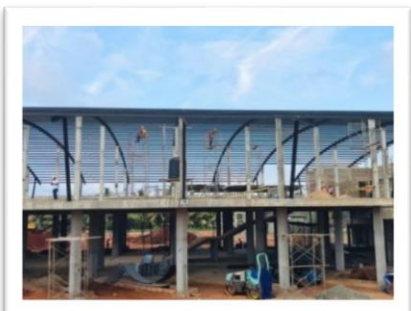
දෙමහල් බස් නැවතුම්පළ ඉදිකිරීම
