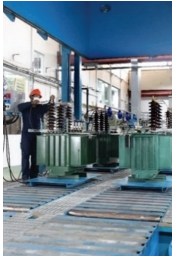
(පහසුකම් සැපයීමේදී ට්‍රාන්ස්ෆෝමර් නිෂ්පාදනයේ අදියර)
