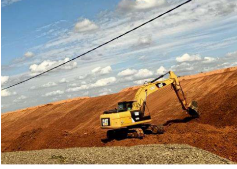
வெபூ ஸூகஹீம் ஸஹ நஹகூலு ஂலீலீம்/ சரீவு தயூரீப்பு மஹ்ஹும் புல் வெட்டுதல்/ Slope Stripping & Turfing
