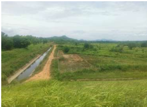
முதன்மை அபிவிருத்தி/ முதன்மை அபிவிருத்தி கட்டுமானம் / Development works on the main embankment road
