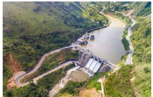
வியரவா சலாஸய/ டயரபா அணைக்கட்டு / Dyaraba Dam
